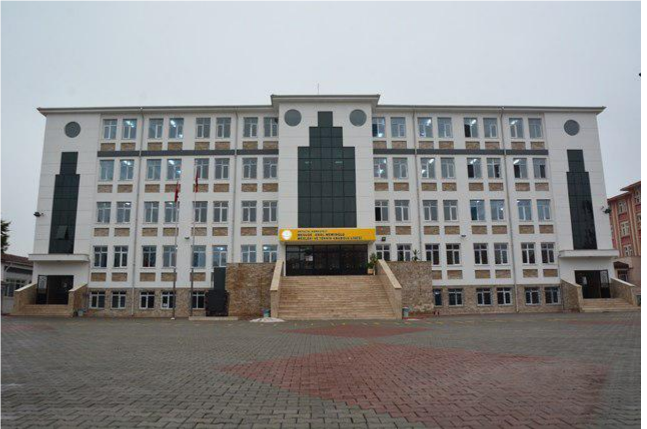
Mesude Erol Memioğlu Mesleki ve Teknik Anadolu Lisesi Binası
